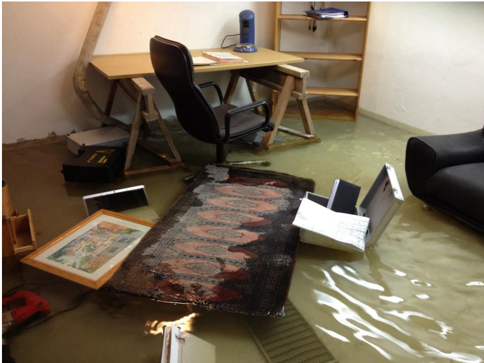
Bild 2: Überflutung eines Kellerraumes nach einem Starkregen, die Elementarschadenversicherung zahlt bei bestimmten Voraussetzungen. Quelle: Jung Pumpen GmbH
